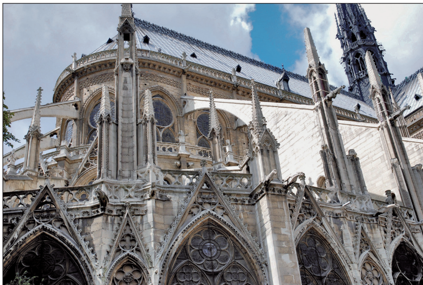
Figura 10. Pináculos, arbotantes y contrafuertes de la catedral de Notre Dame en París.
