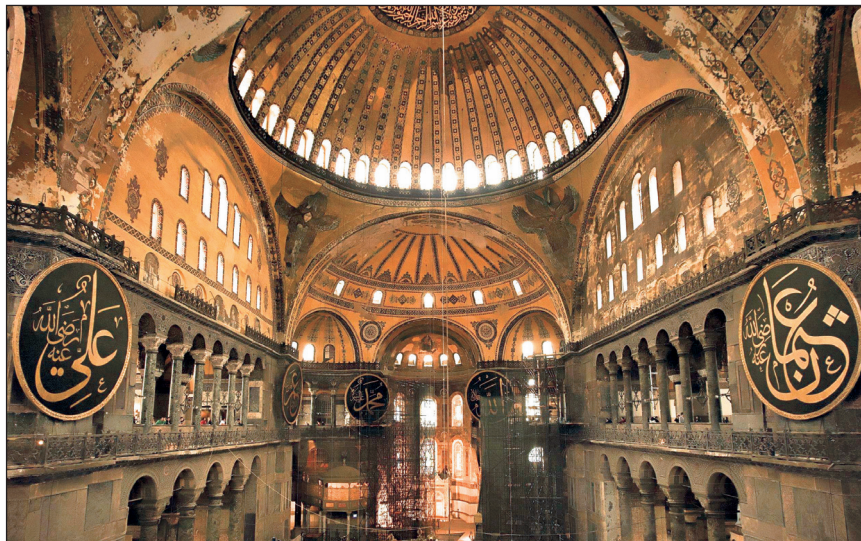
Figura 8. Interior de la basílica de Santa Sofía de Constantinopla (532-537).
